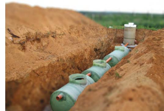
*Локальные очистные сооружения от компании МФМК могут быть реализованы как по накопительной, так и по проточной схеме.*
