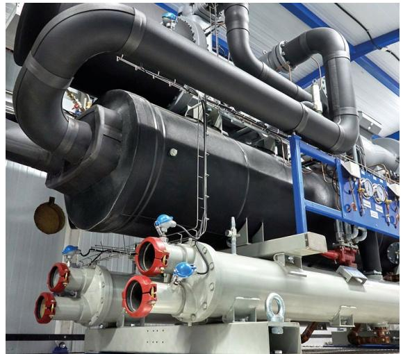
Блочная холодильная установка Эпсилон Frost® БХУ 600-2В-1КК-1ИК- R134a в комплекте с ЗИП, суммарной холодопроизводительностью 2520 кВт.
